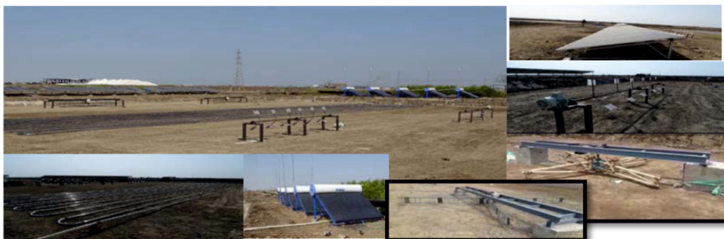
चित्र: साल्ट पॉन्ड में वाष्पीकरण दर बढ़ाने के लिए एक अभिन्न प्रणाली के लिए पायलट पैमाने पर प्रदर्शन इकाई Fig.: Pilot-scale demonstration unit for an integral system to enhance evaporation rate in the salt pond
