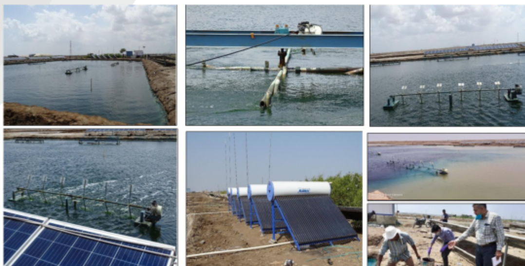
चित्र: मौजूदा साल्ट पॉण्ड क्षेत्र में ब्राइन के वाष्पीकरण के लिए पायलट-स्केल इंटीग्रेटेड सिस्टम का विकास एवं प्रवर्तन
